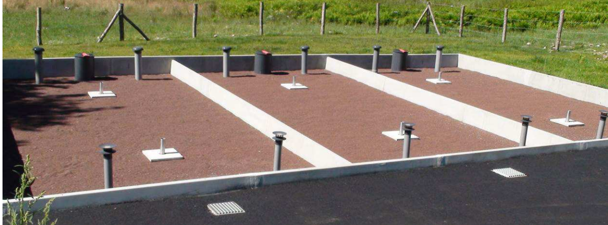
Figure 3 Illustration d'un 1 er étage Ecophyltre (©J.Voisin)
